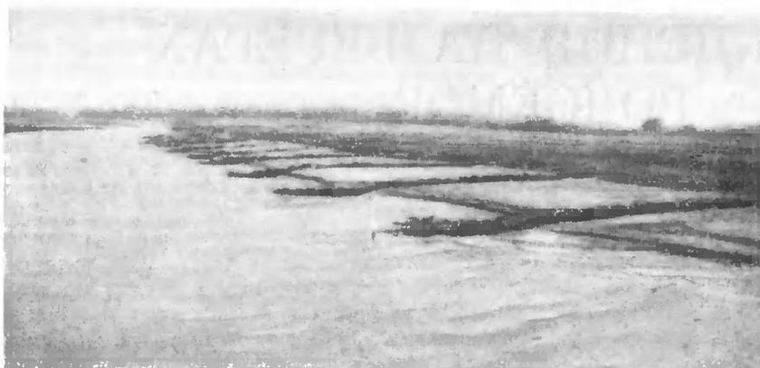
Рис. 2. Для того чтобы не размывло грунт тогда, когда саженцы еще не проросли, устраивают систему шпор из плетней, хворостяной выстилки и камней
